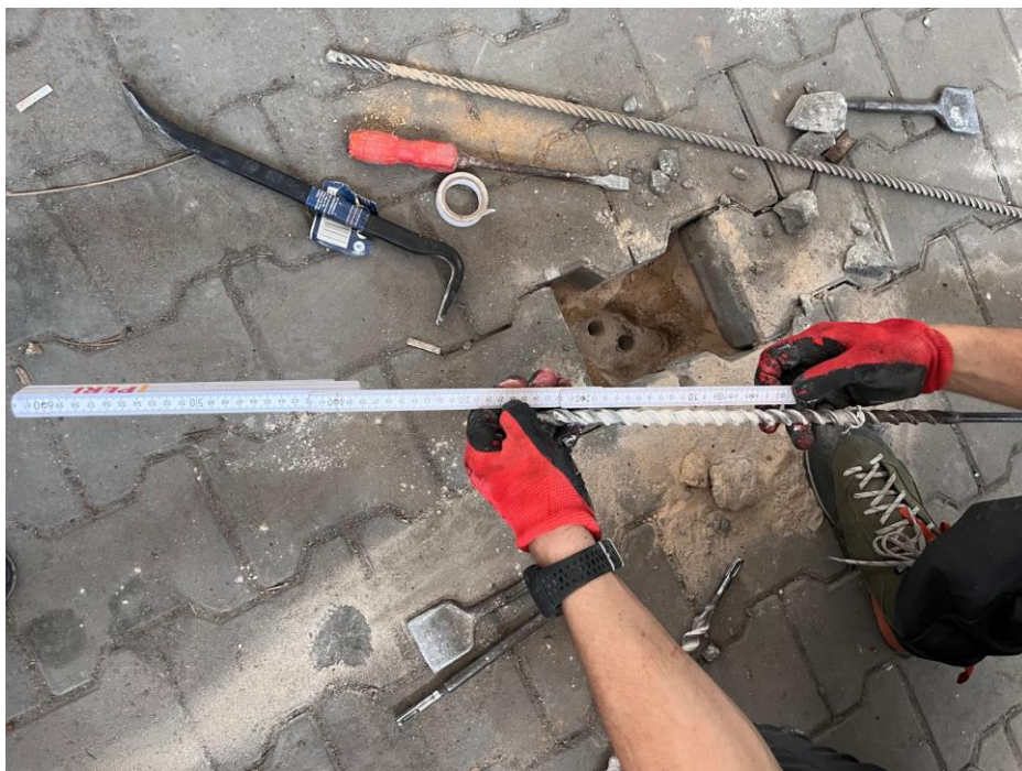
Zdjęcie 2 posadzki. Zdjęcia dokumentujące odwiert przez posadzkę
